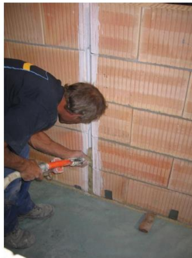
Fig. 6: Opvulling met mortel
